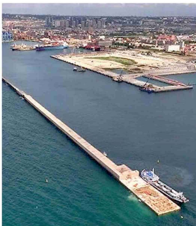
I lavori di prolungamento della Diga e la Darsena di Levante a Napoli
